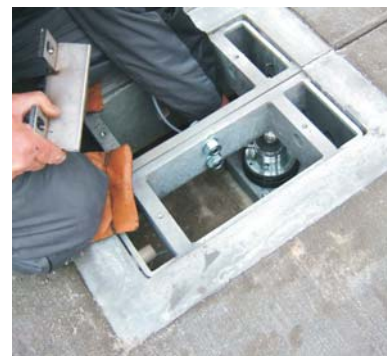
Veiecellene monteres og tilkobles.
