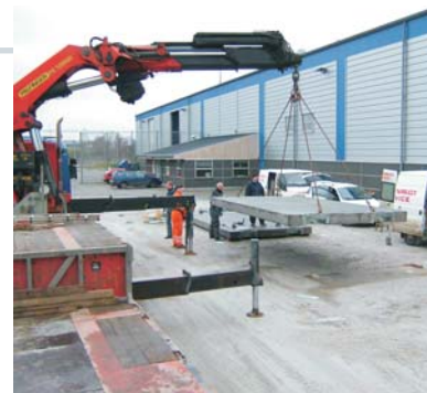
Broen plasseres på fundamentene.
