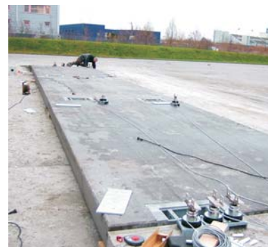
Kabler trekkes til veiecellene.
